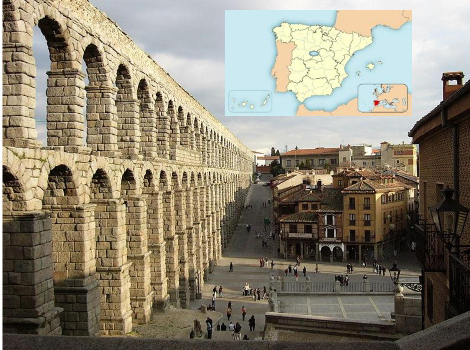
接着剤を使わずに20,400個の石のみでできた、全長728m、163ものアーチから成る水道橋は、その大きさと重厚な佇まいで見る者を圧倒します。まさに人類の英知の結晶とも言えるべき遺跡のひとつです。
